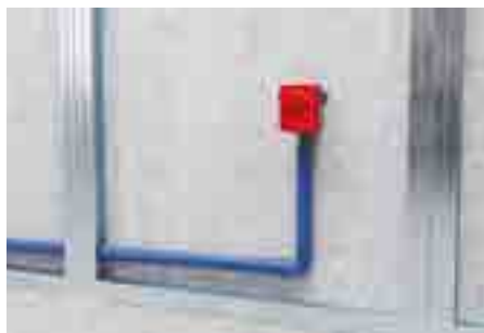
2. Odvodnu cev na kućište priključiti.
